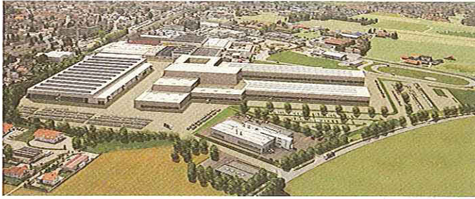
Erweiterung des Fendt-Werkes Marktobersdorf bis 2012, mit einer geplanten Produktionskapazität von 20 000 Traktoren.
